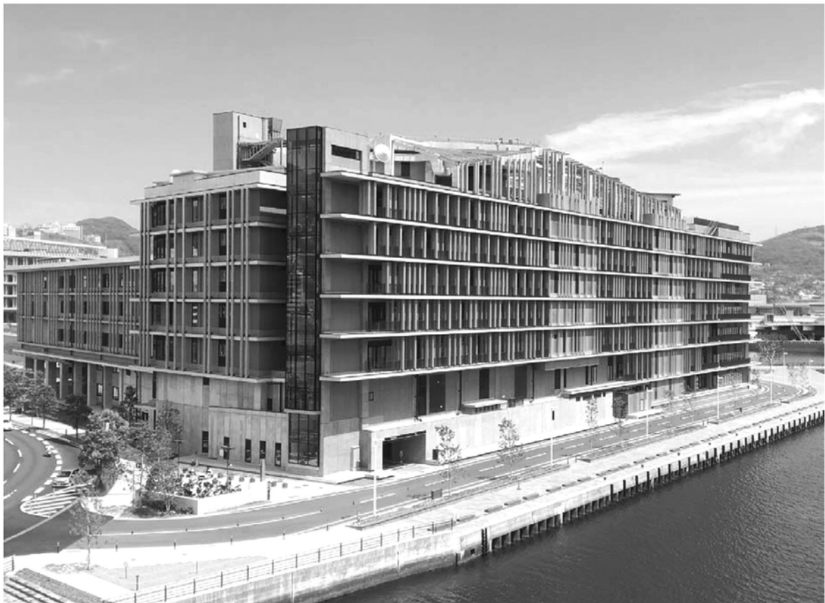
写真1 新長崎県庁舎外装木製ルーバー
