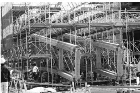
写真-2 多目的競技場の屋根トラスの骨格
