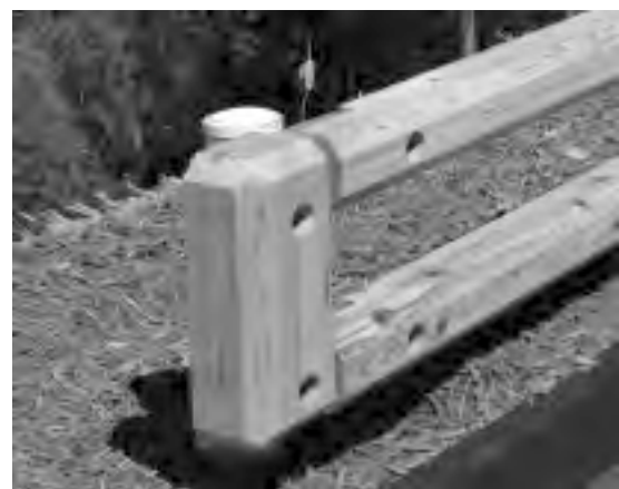
(エコアコールウッド C 種ガードレールの部材)
