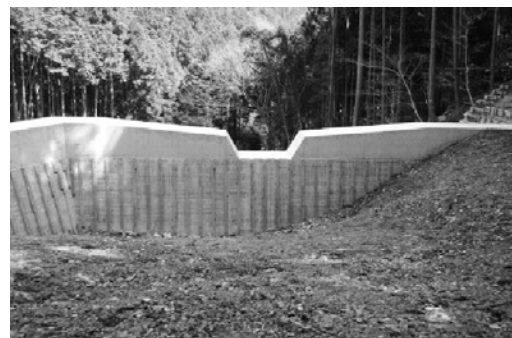
山腹内の表土流出防止等の目的で設置
