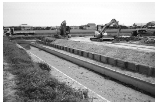
クリーク護岸の土留めを目的として設置
