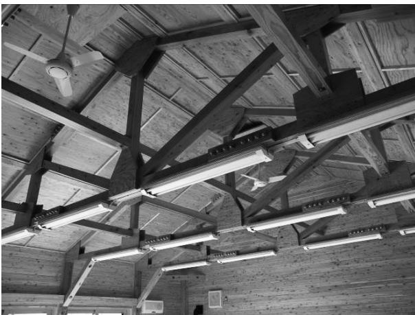
カラマツ無垢材でトラス構造を組んだ天井
