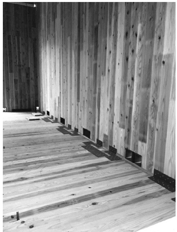
平均200mmピッチで入っているアンカーボルト
