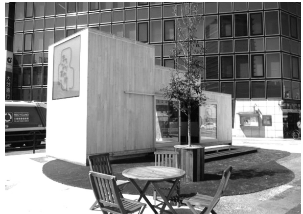
写真2 CLT構造による観光案内所
