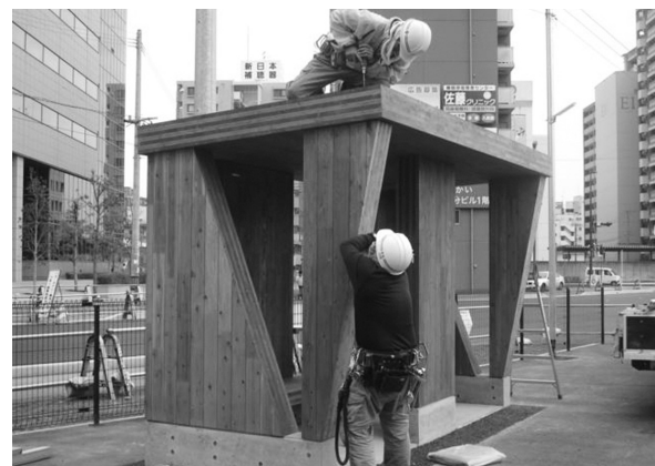
写真3 CLT構造によるバス停留所
