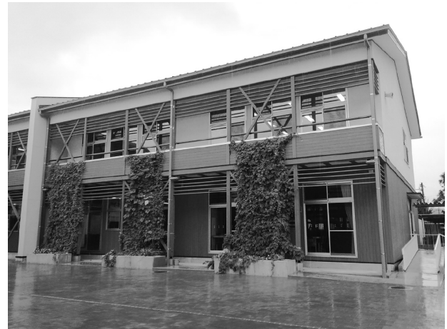
(写真2 完成後半年の様子)
