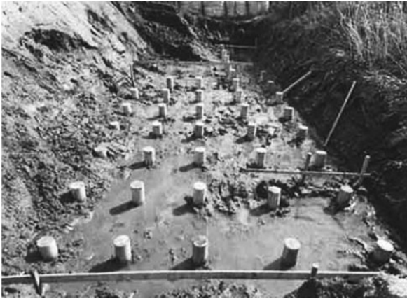
写真5 丸太杭による地盤改良
