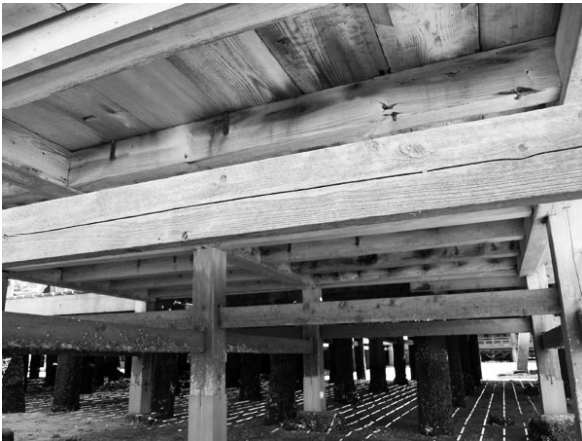
写真8 海中に沈む束の保存処理材による修復 (広島県 厳島神社)
