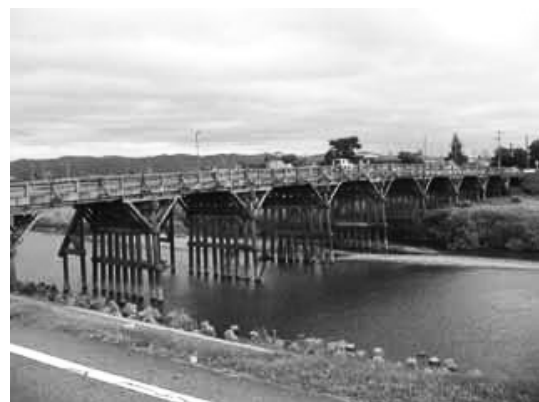
写真1 コンクリートがなかった時代の木橋
