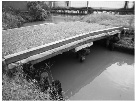
写真3 地域の製材品と丸太で造られた簡易木橋 事例 (福岡県大川市)
