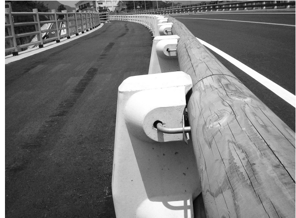
写真9 国道で初めて設置された木製ガードレール (宮崎県高千穂町)
