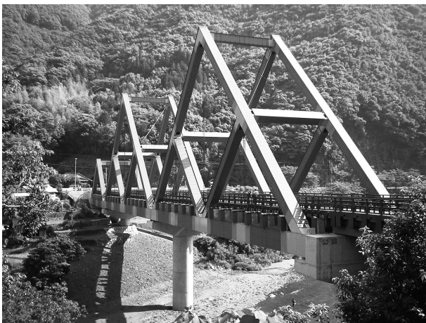
写真2 強度設計された近代木橋 (宮崎県：かりこぼうず大橋)
