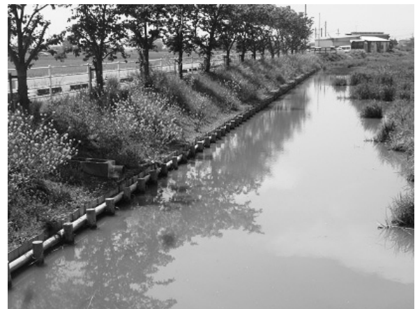
写真7 景観に配慮した用水路木柵土留め工
