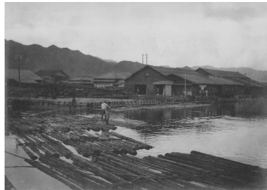
図-1 弁甲材 (堀川運河)
