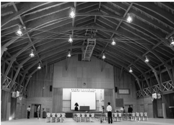
地材地建で造られた鶴居小学校体育館
