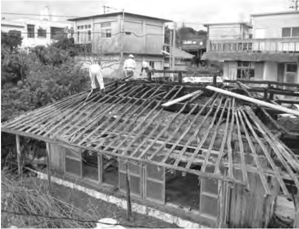
写真3 古民家の解体 首里より移築された築100年の民家、南城市安里 (長堂昌次郎氏提唱)
