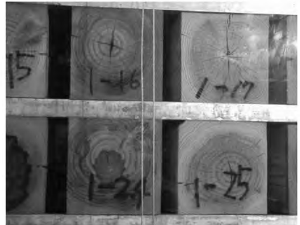
写真4 木口割れ発生の様子
