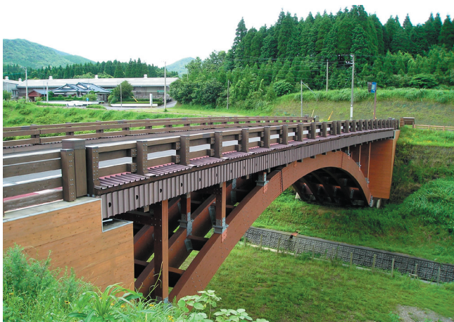
日本一のスギ車道橋（金峰 2000 年橋）
