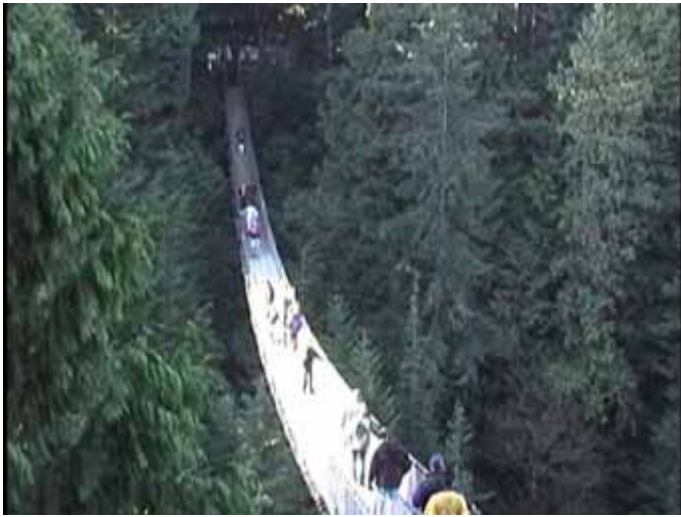
写真5 カビラノ吊橋
