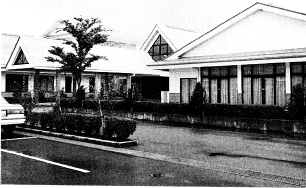
スギ構造用大断面集成材を多用した木 造建築物（宮崎県都城保健所）
