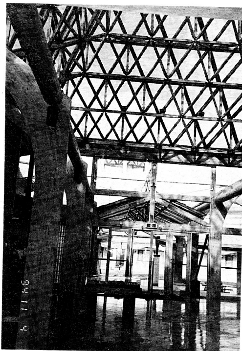
本館ホールの集成材と木造トラス
